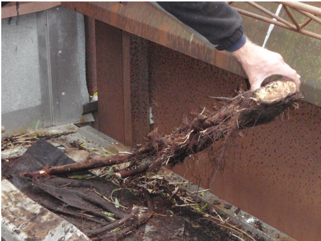
Rod fra et piletræ, som var på vej ned i afløbet - det tog halvanden dags arbejde for to-tre gårdmænd at få bugt med det!
