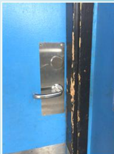
Mekanisk sikring (ved alle indgangsdøre)
