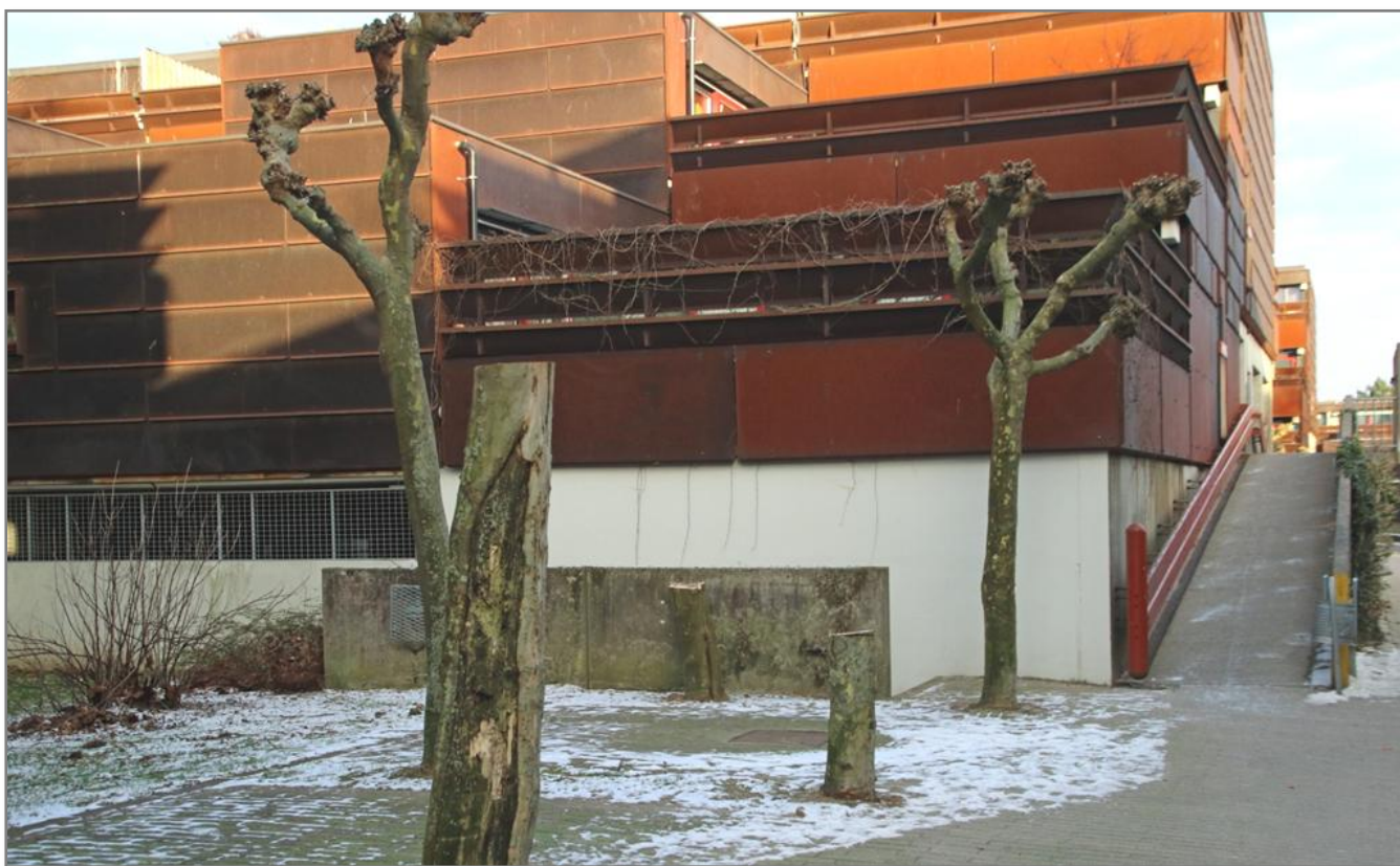
Foto: Hans/FAU – Platantræer mellem blok 21 og 22
