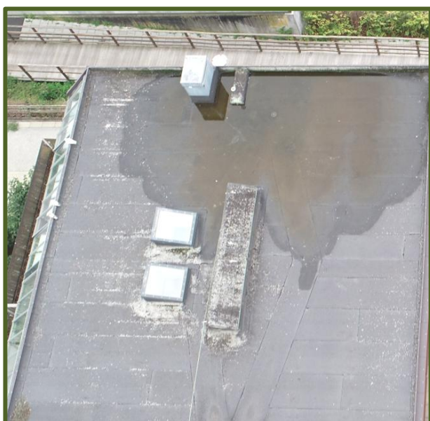
Data fra dronen – vand på et højtage
