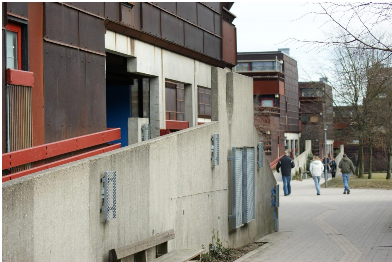
Foto: Hans/38 2.R – 28.02.2009 – Ved Stenalderpladsen
