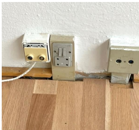
Foto 9: Gulv lagt i modsat retning
